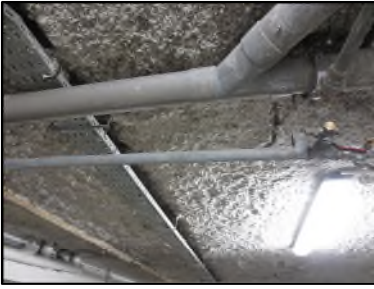
Photo N° 584 ECH-N°1 FLOCAGE -- PARKING Plafonds BLANC COTONNEUX
